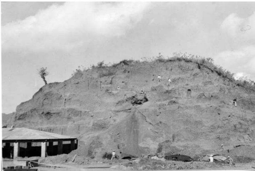
El montículo E-III-3 previo a su destrucción
